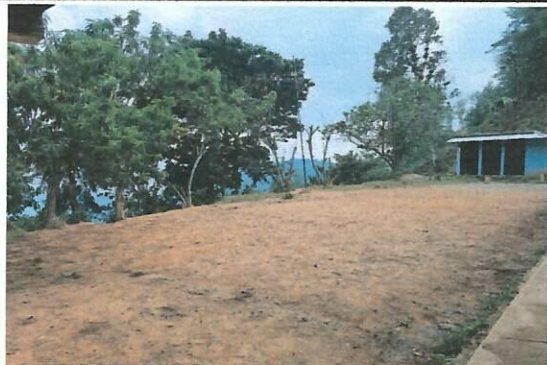
Foto 1: Se realizará el mejoramiento e instalación de estructura metálica tipo pórtico
